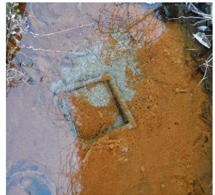
図7 鉄バクテリアによる被膜
